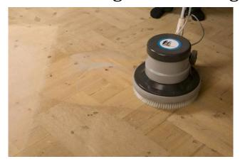
In der Regel erfolgt eine Grundreinigung mit einer anschließenden Auffrischung der Öloberfläche im Zuge der normalen Nutzung mit FAXE Pflegeöl Plus oder FAXE Oilotion
