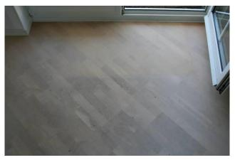
Nach Intensivreinigung und Entgrauung mit Laubholzlauge, noch nicht vollständig getrocknet. Die gelbliche Färbung weist auf Bereiche mit erheblich verschlissener Öloberfläche hin.
